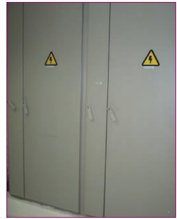
Los locales técnicos deben tener compartimentación y señalización adecuadas.
