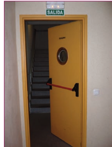
Las escaleras sin independizar favorecen la propagación del incendio y de los humos. Las puertas de sectorización deben existir también en las escaleras de cada planta del edificio, tal como muestra la imagen.
