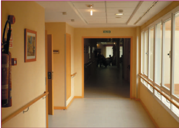
Imágenes de pasillo protegido: ventanas o huecos (ventilación). Permite circular hasta la escalera y salida del edificio (Imágenes de Caser Residencial Arturo Soria.).
