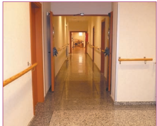
Las puertas situadas en las vías de evacuación deben permanecer abiertas continuamente, pero con sistema automático de cierre en conexión con el sistema de detección de incendios.
