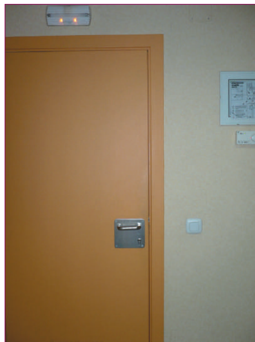
El alumbrado de emergencia permite una evacuación segura y fácil.
