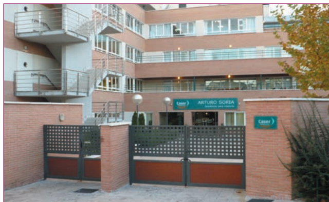
Centro con correcta salida de evacuación y escalera de emergencia. Salida de uso habitual y salida de emergencia.
