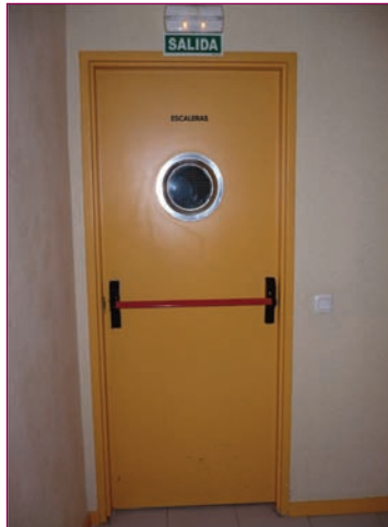
Las escaleras sin independizar favorecen la propagación del incendio y de los humos. Las puertas de sectorización deben existir también en las escaleras de cada planta del edificio, tal como muestra la imagen.
