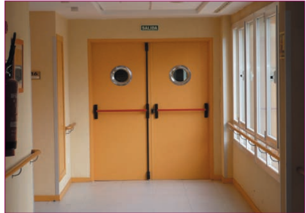
Imágenes de pasillo protegido: ventanas o huecos (ventilación). Permite circular hasta la escalera y salida del edificio (Imágenes de Caser Residencial Arturo Soria.).
